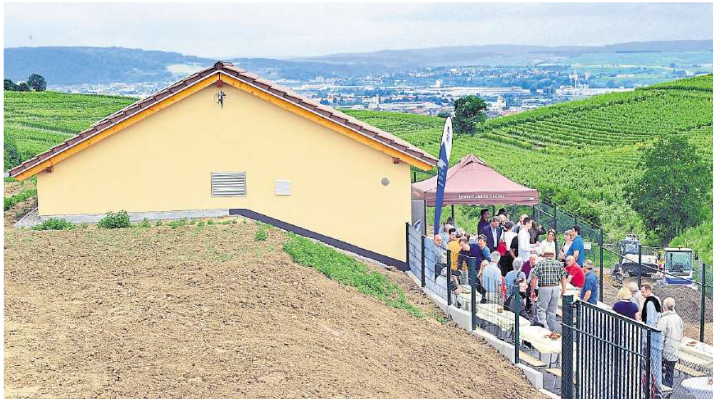
Der neue Wasserspeicher steckt voller moderner Technik und hat nicht mehr viel mit der „Wasserturm“-Optik zu tun. Foto: Thomas Schmidt
