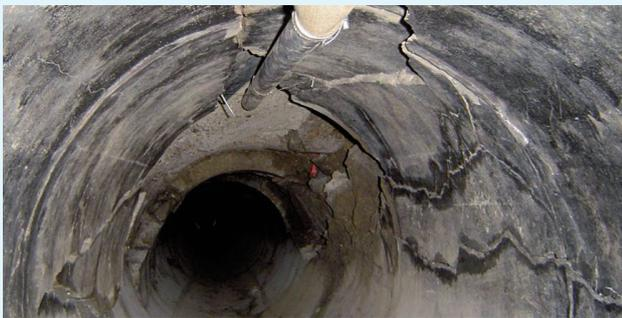
*Deformierte Abwasserkanäle verschlechtern die Statik des Kanalsystems und erhöhen die Einsturzgefahr.*
