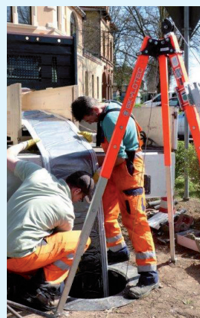
Einzug des UV-Inliners, bestehend aus einem GfK-Verbundsystem in den Kanalschacht
