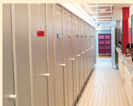
Frisch sanierte Umkleide
