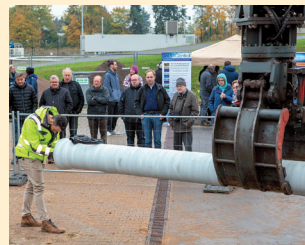
Ein Bagger der Köhler Bau GmbH zeigt, wie Rohre verlegt werden
