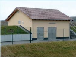
Der neue Hochbehälter Sprendlingen mit einem Gesamtvolumen von 1.200 m<sup>3</sup> Trinkwasser.
